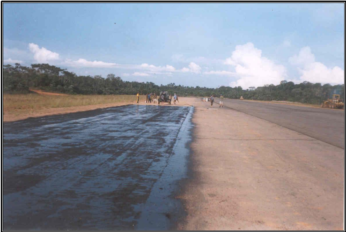
VISTA PANORAMICA DE LA IMPRIMACIÓN ASFÁLTICA
