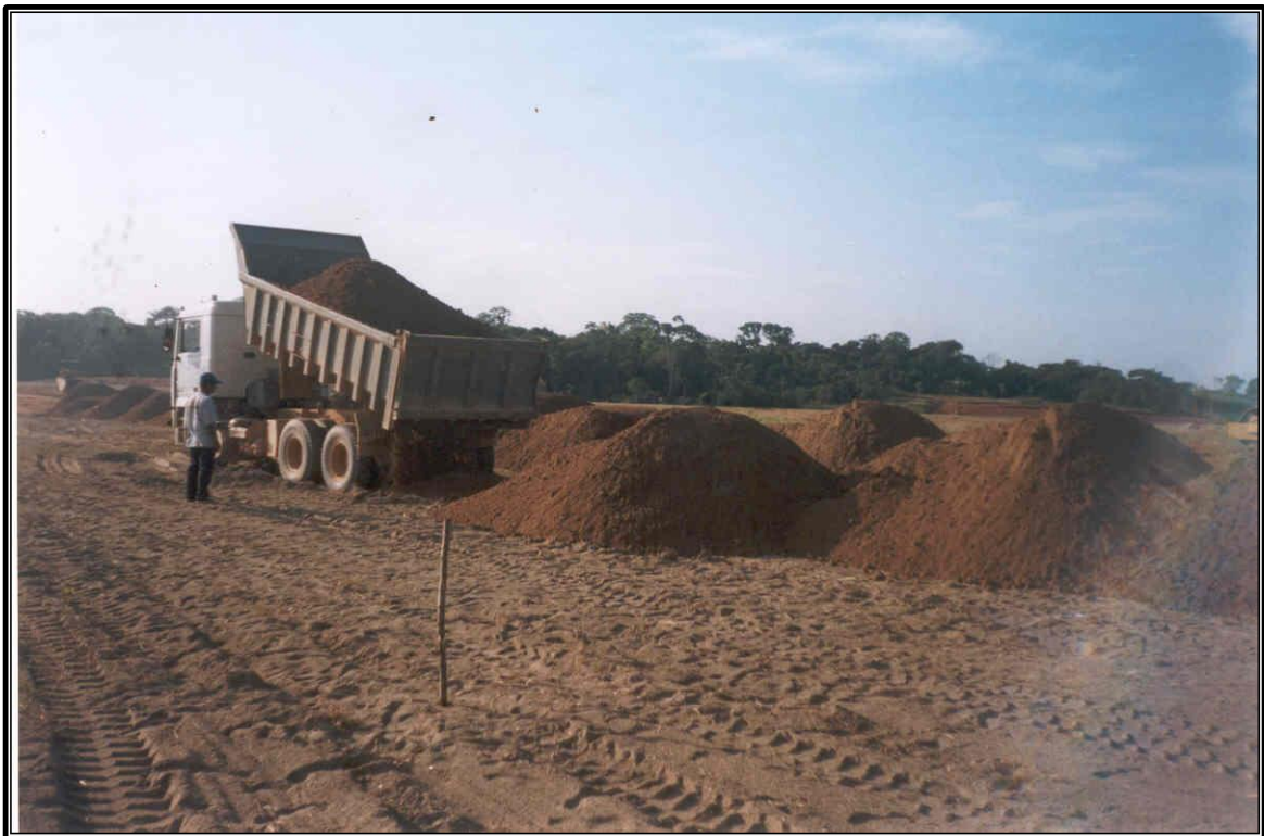
DESCARGA DE MATERIAL PARA LA SUB BASE EN LA PLATAFORMA
