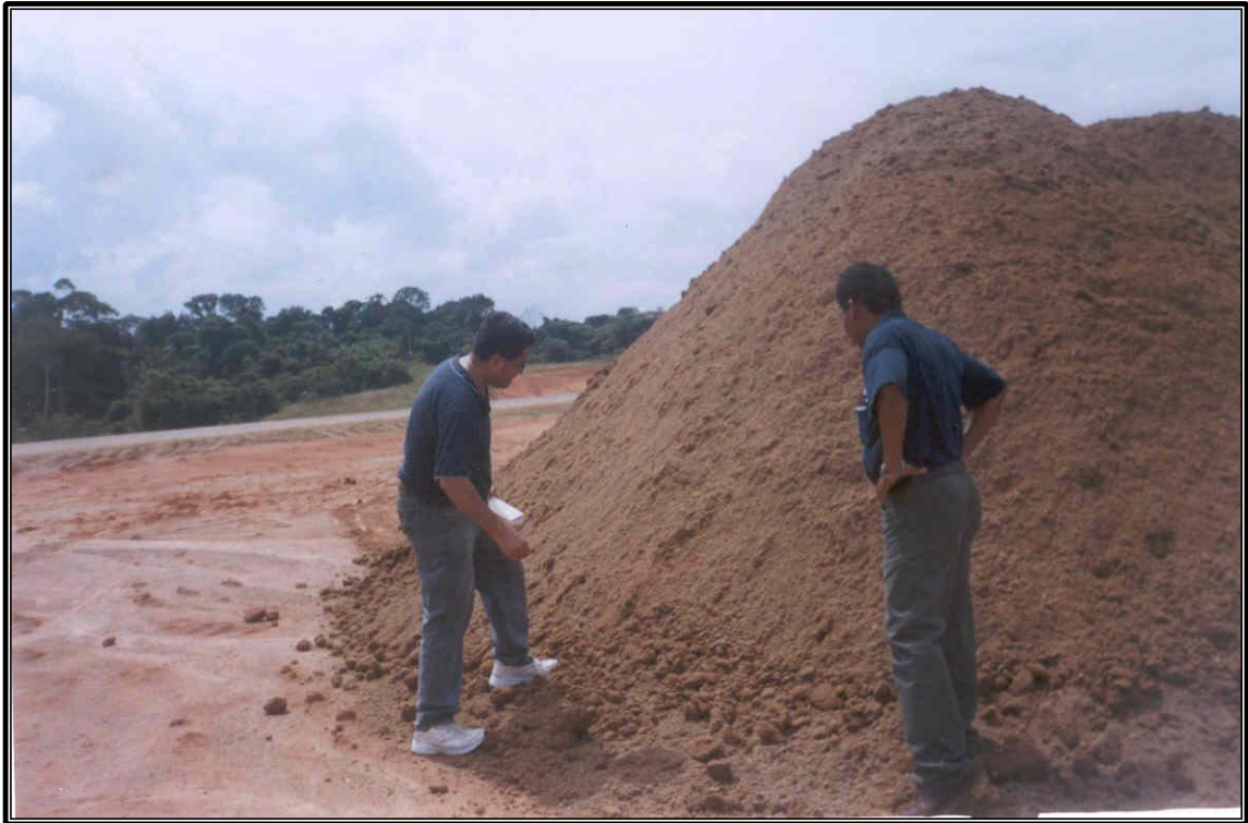
VERIFICACIÓN DEL MATERIAL EN CANCHA IN SITU
