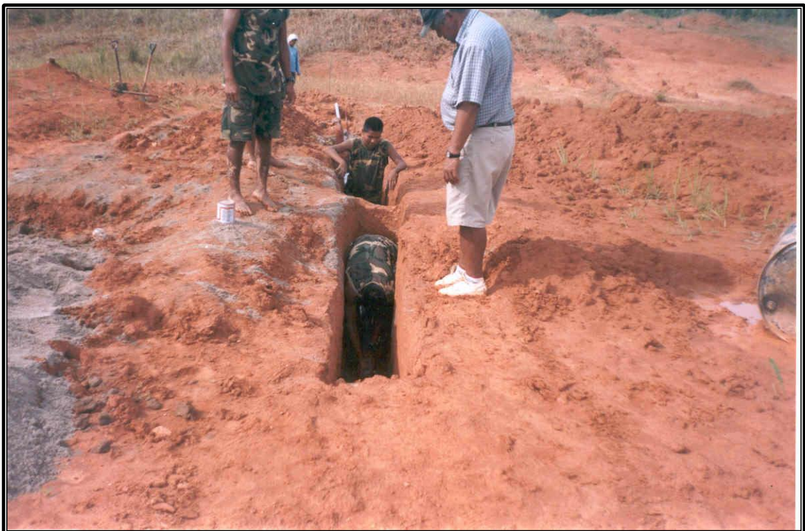
EXCAVACIÓN DE ZANJAS PARA LA COLOCACIÓN DE LA TUBERIA DE DRENAJE DE LA PLATAFORMA
