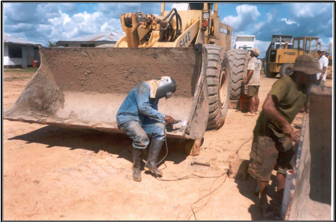
MANTENIMIENTO DEL EQUIPO MECÁNICO UTILIZADO EN OBRA
