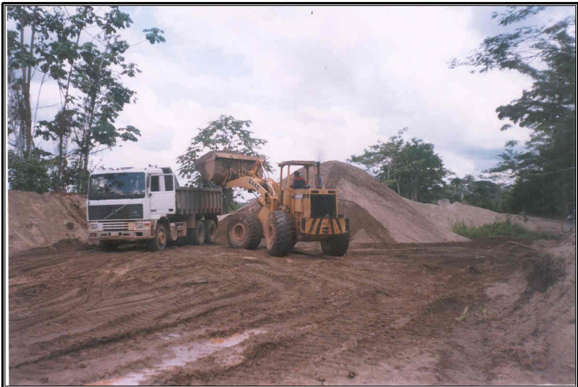
CARGUIO DEL MATERIAL PARA LA COLOCACIÓN DEL MORTERO ASFÁLTICO
