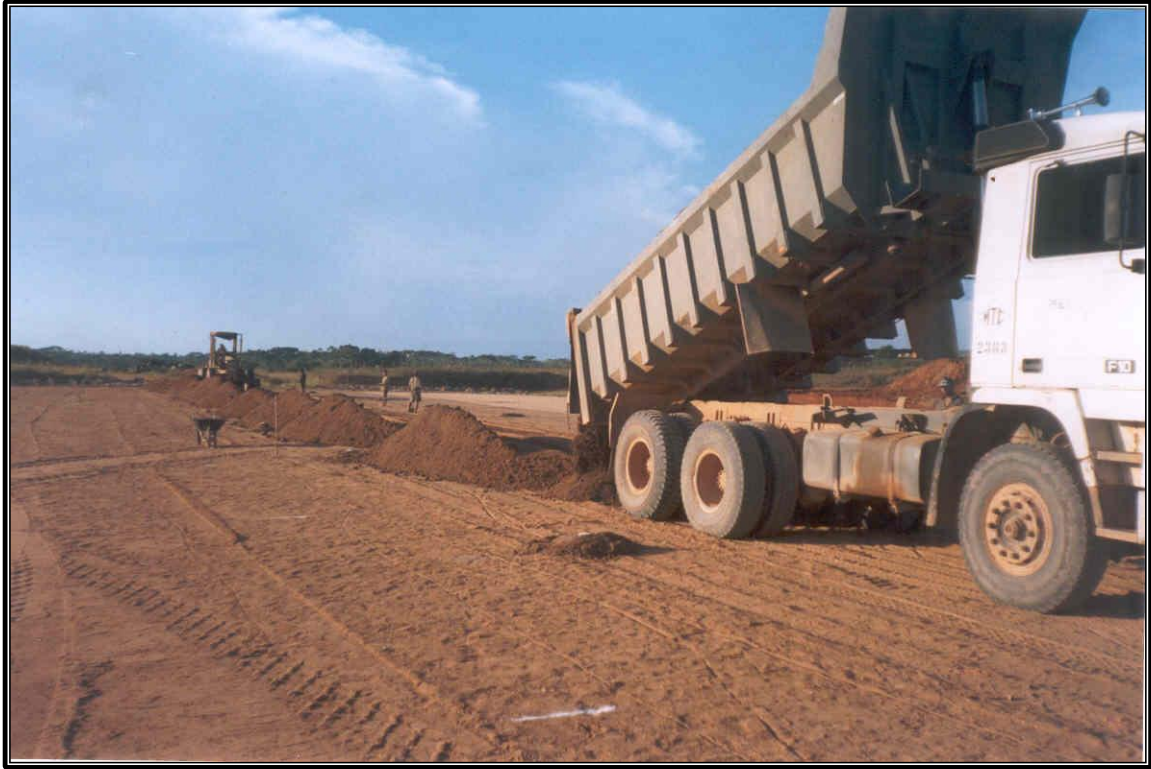
COLOCACIÓN EN LA PLATAFORMA DE MATERIAL BATIDO
