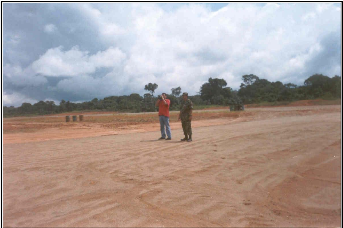
VERIFICACIÓN DE LOS TRABAJOS DE SUB BASE EN LA PLATAFORMA Y EN LA CALLE DE RODAJE DE SALIDA
