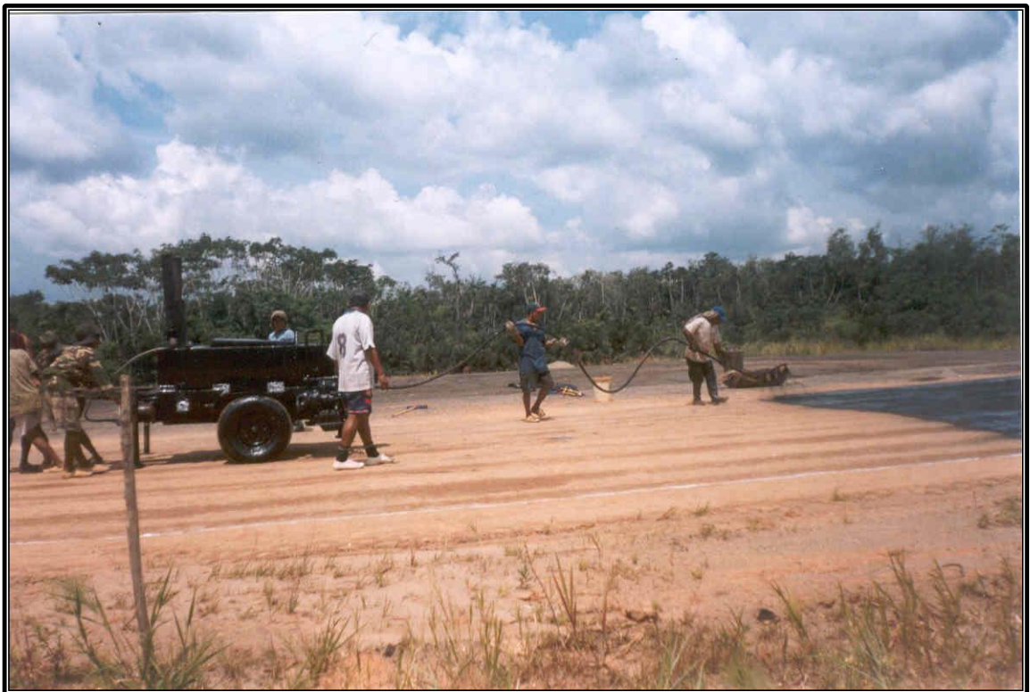
IMPRIMACIÓN DE LA BASE CON RC-250
