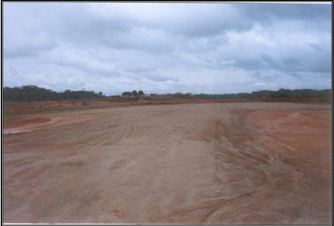
SE APRECIA LA SUB BASE EN LA PLATAFORMA DE ESTACIONAMIENTO Y EN LA CALLE DE RODAJE DE SALIDA
