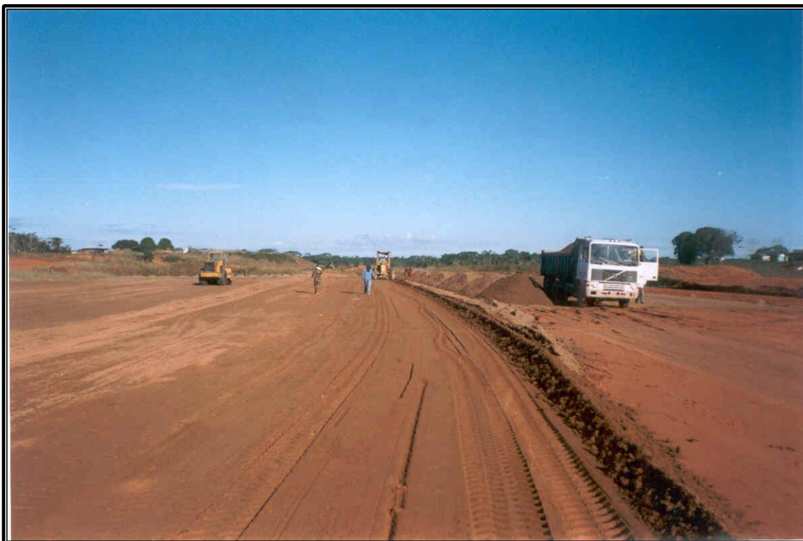
CONFORMACIÓN DE LA SUB BASE DE LA PLATAFORMA DE ESTACIONAMIENTO
