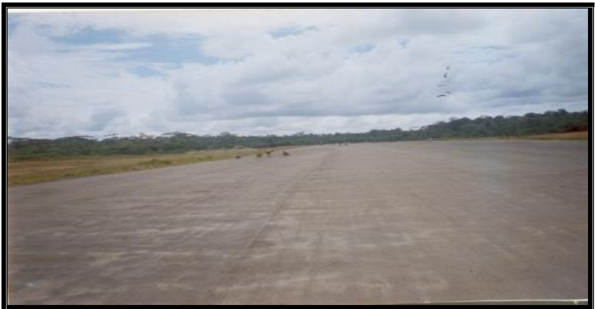
VISTA DE LA PISTA PRINCIPAL DESPUÉS DE LA COLOCACIÓN DEL MORTERO ASFÁLTICO
