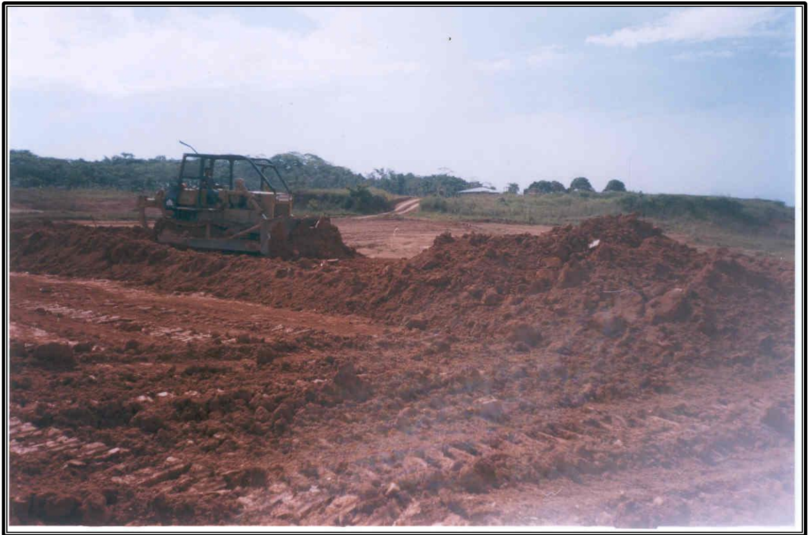
CORTE DE MATERIAL SUELTO
