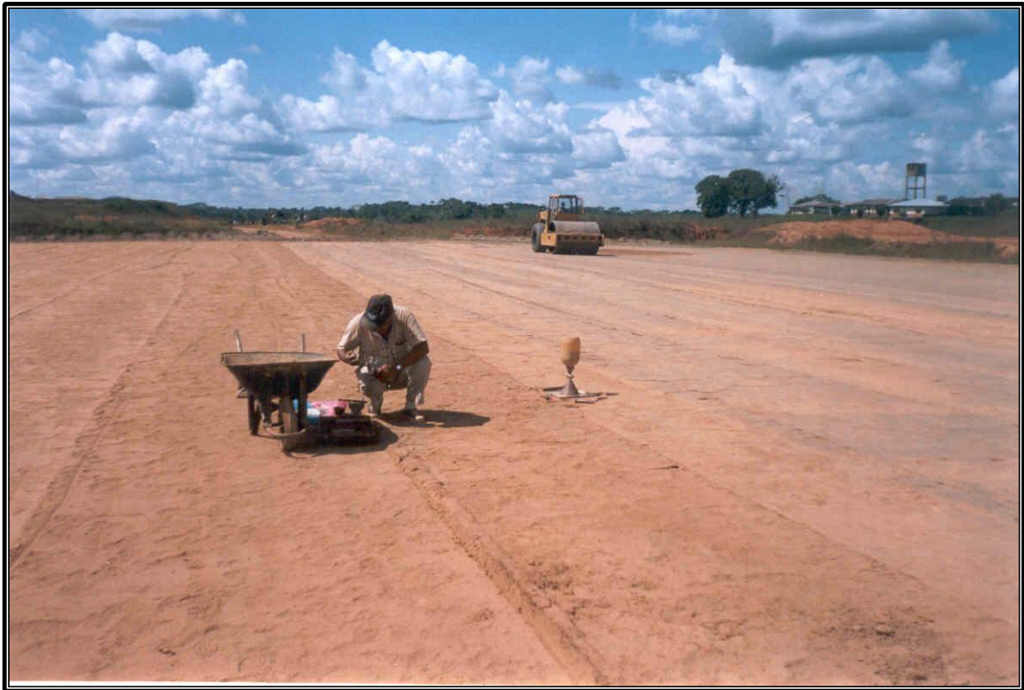
TOMA DE PRUEBAS DE DENSIDAD EN EL CAMPO EN LA PLATAFORMA
