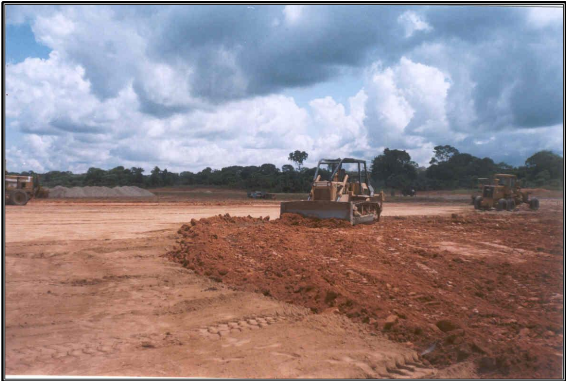
TRABAJOS EN LAS MÁRGENES LATERALES DE LA CALLE DE RODAJE DE SALIDA Y DE LA PLATAFORMA
