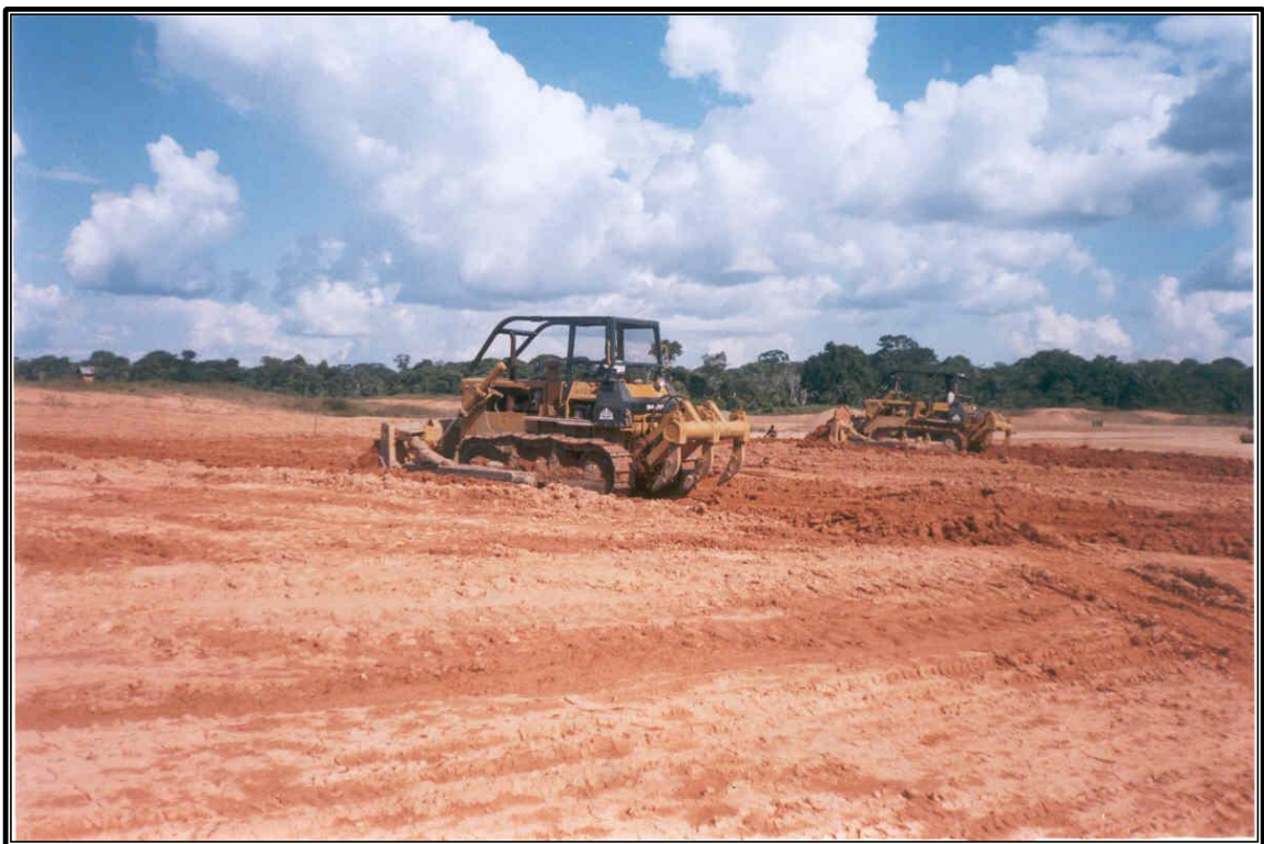
TRABAJOS EN LAS FRANJAS LATERALES DE LA PLATAFORMA
