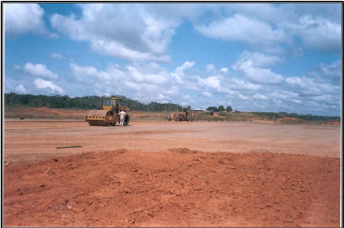
PERFILADO Y COMPACTACIÓN DE LA SUB BASE EN LA PLATAFORMA
