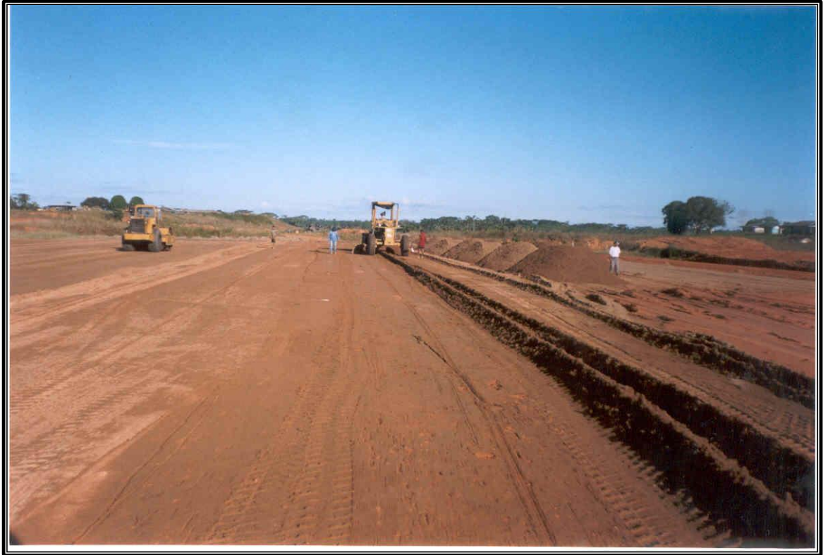
ESPARCIDO, NIVELACIÓN Y COMPACTACIÓN DE LA SUB BASE
