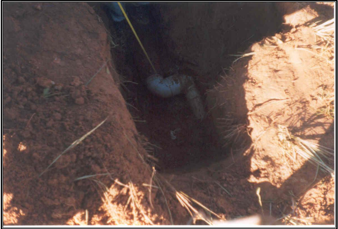
COLOCACIÓN DE LOS EMPALMES EN LAS TUBERIAS DE DRENAJE
