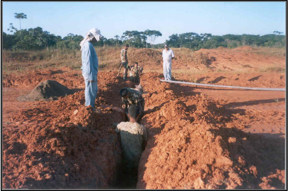
COLOCACIÓN DE LA TUBERIA DE DRENAJE
