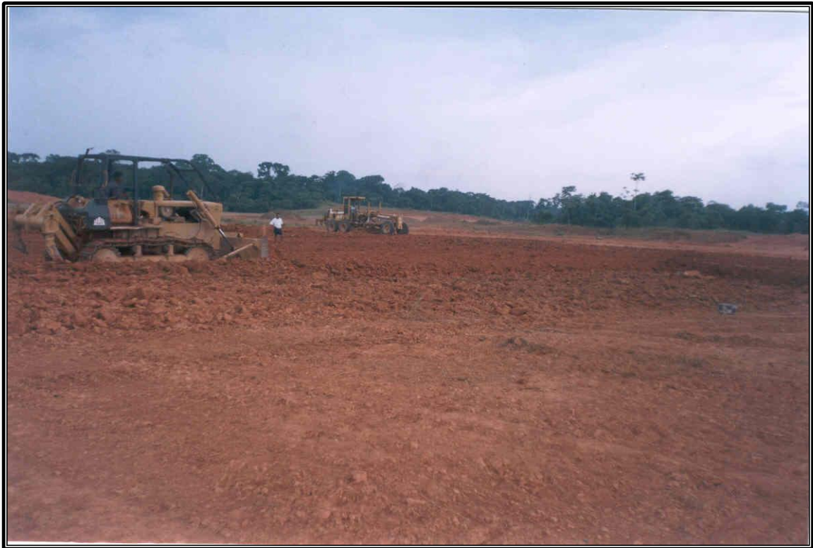
CORTE Y PERFILADO EN LAS FRANJAS LATERALES
