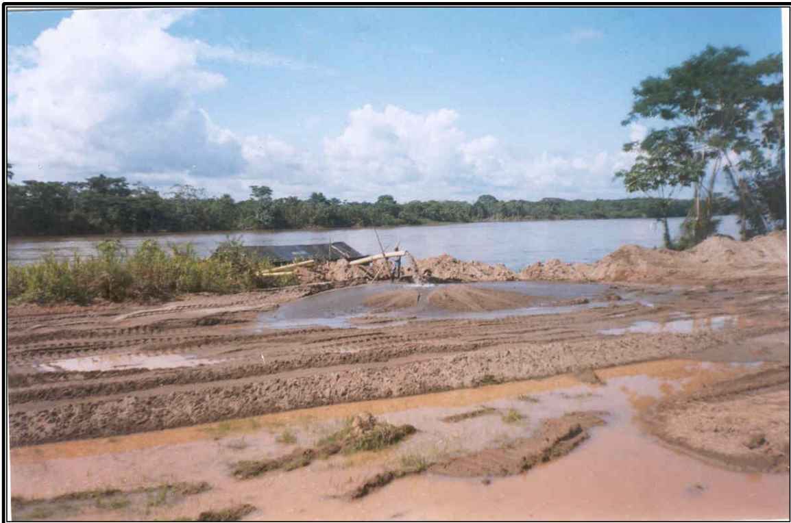
EXTRACCIÓN DE MATERIAL UTILIZANDO LA DRAGA
