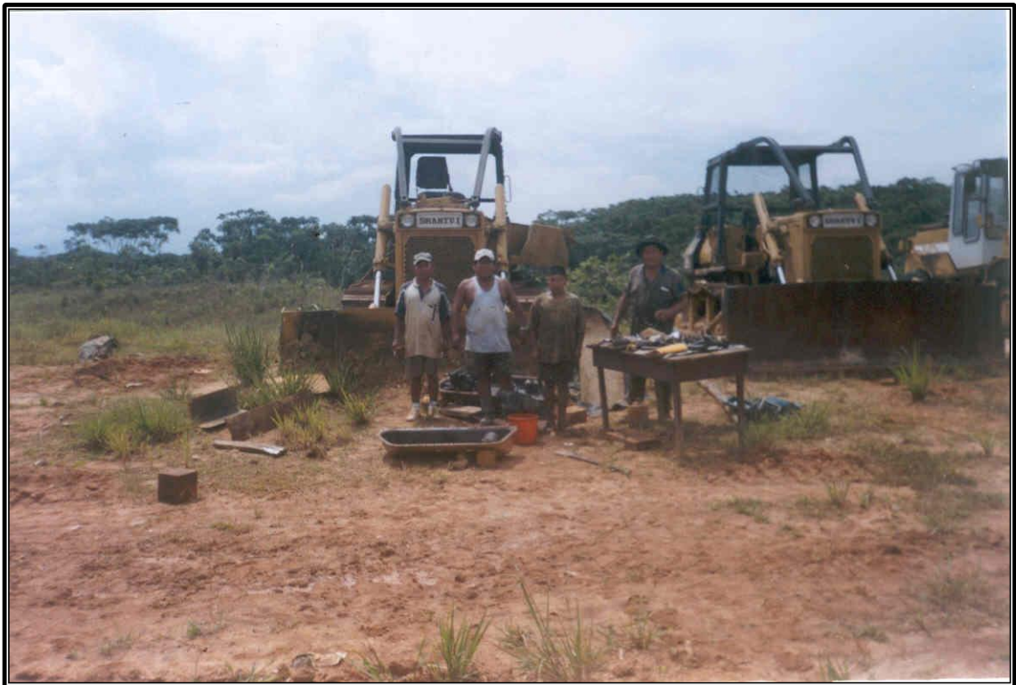
REPARACIÓN DEL EQUIPO MECÁNICO
