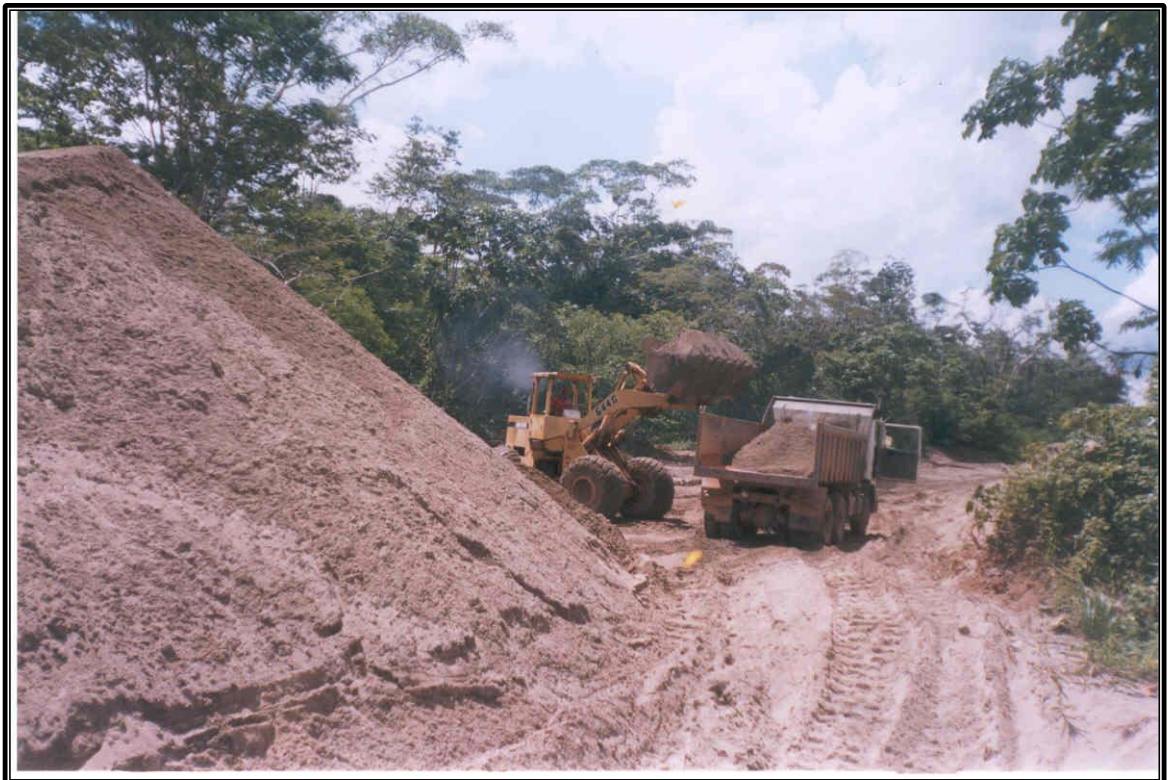
CARGUIO DE ARENA PARA LA CONFORMACIÓN DE LA SUB-BASE
