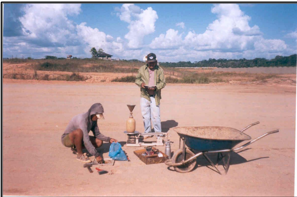
VERIFICACIÓN DE LA DENSIDAD DE CAMPO DE LA SUB-BASE
