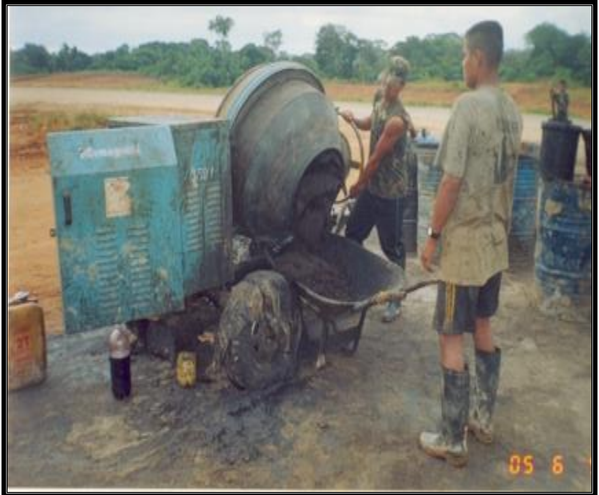
PREPARACIÓN DEL MORTERO ASFÁLTICO
