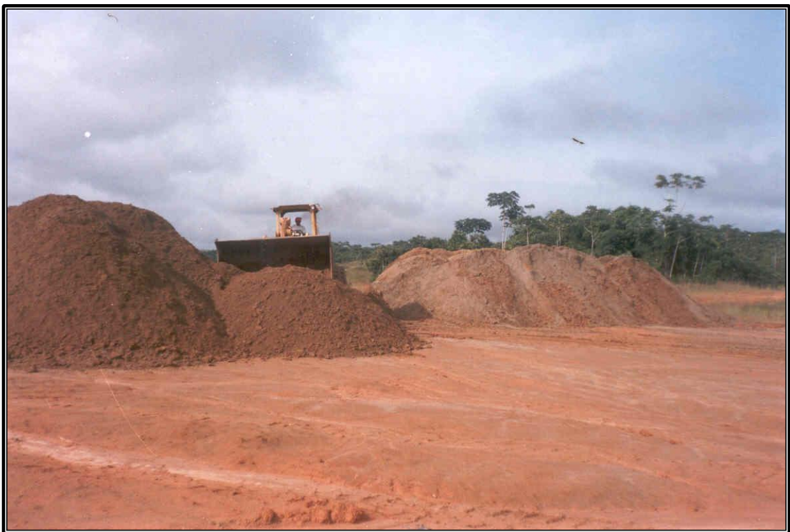
EXTRACCIÓN DE ARCILLA PARA LA CONFORMACIÓN DE LA SUB BASE
