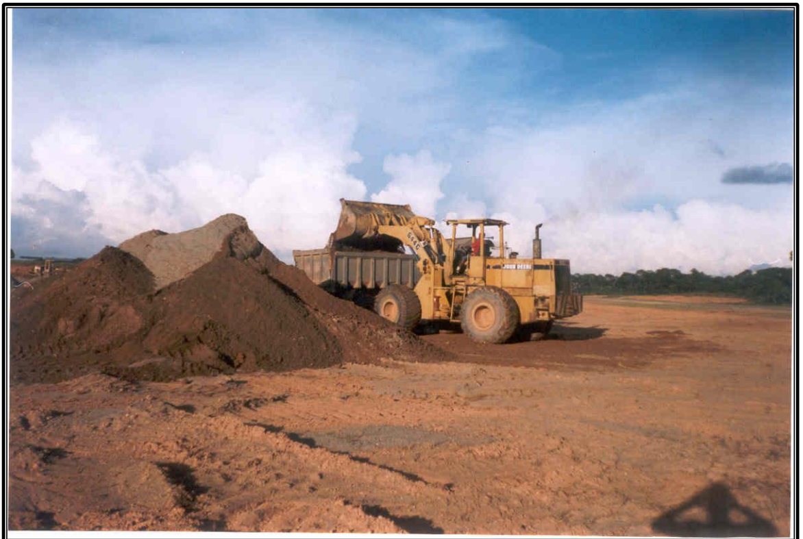
TRASLADO DE LA MEZCLA DEL MATERIAL ARENA Y ARCILLA PARA LA SUB BASE
