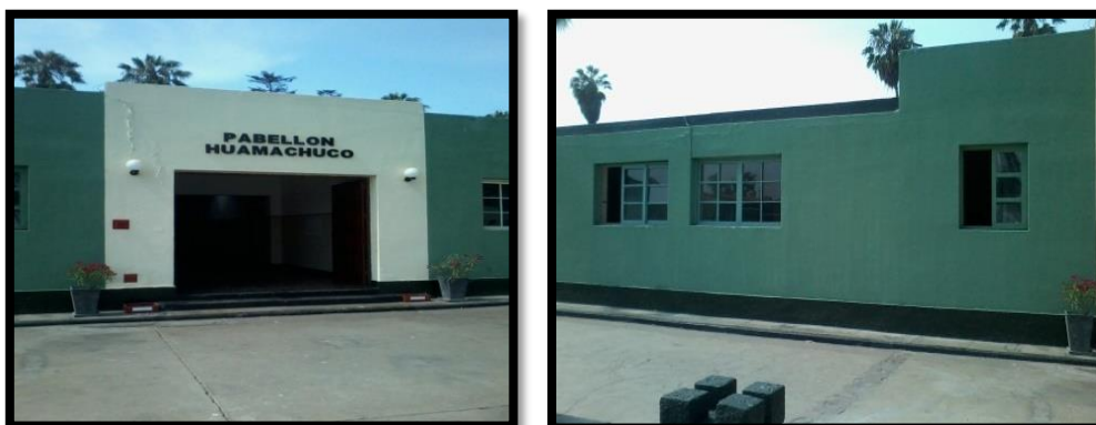
Figura 5: La situación de la ubicación inadecuada.
