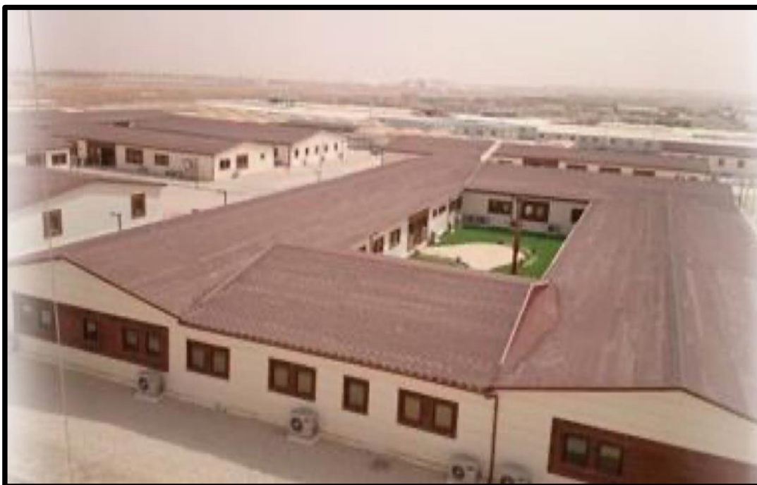
Fotografía aérea de la Base Contrasubversiva
