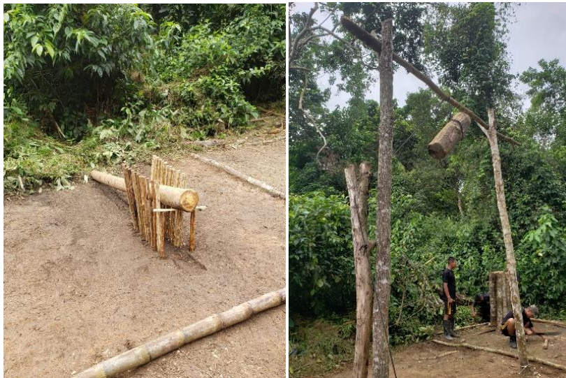
Figura 15 Construcción de soportes
