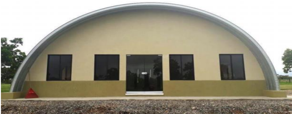
Figura 5 Almacén con sistema K-SPAN
