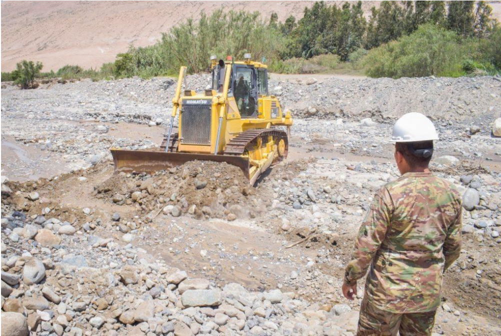
Figura 6 Limpiando laderas del rio
