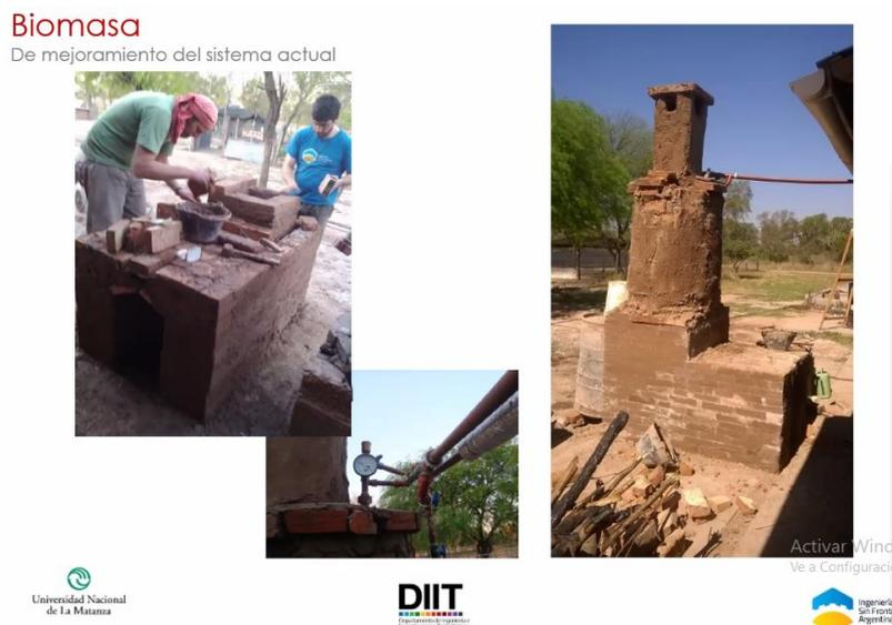
Foto N° 9: Construcción de calentador de agua.
