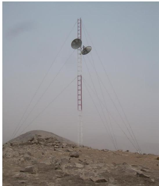
Figura 6: Repetidora pasiva Back to Back
