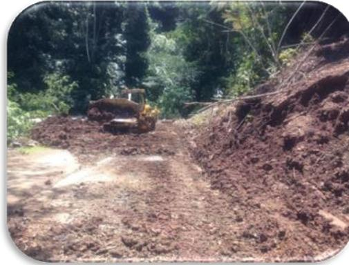
Figura 26. Explanaciones. Corte de material suelto.
