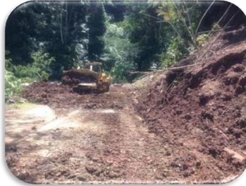
Figura 26. Explanaciones. Corte de material suelto.
