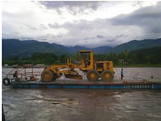
Figura 25. Movilización del Equipo Mecánico. Cruzando el río Apurímac.
