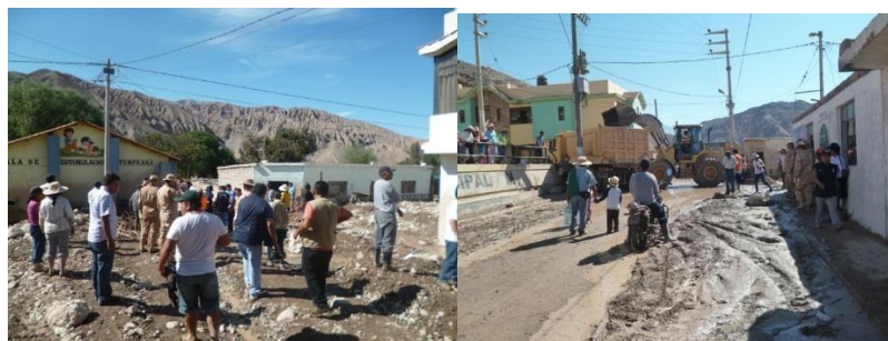
Figura 37. Trabajos en beneficio de los CCPP de Ilabaya, Mirave y Locumba
