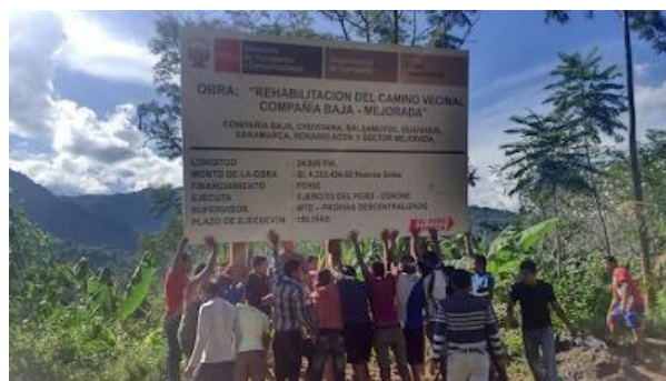
Figura 21. Instalación del cartel de obra
