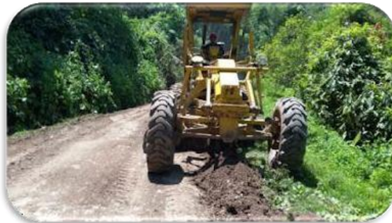
Figura 28. Explanaciones. Perfilado.
