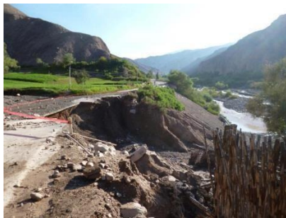
Figura 36. Reposición de plataforma. Empleo del equipo mecánico del B Ing CB N° 6.
