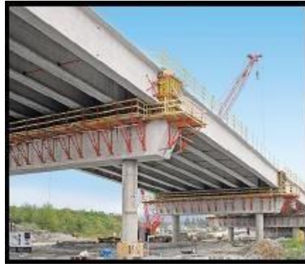
Figura 16. Puente tipo viga
