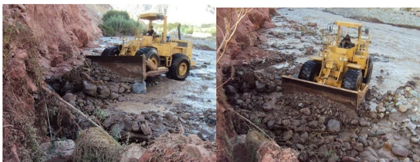
Figura 38. Trabajos en beneficio de los CCPP de Ilabaya, Mirave y Locumba
