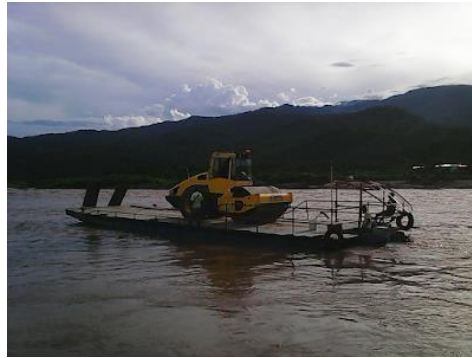
Figura 24. Movilización del Equipo Mecánico. Cruzando el río Apurímac.
