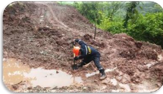
Figura 27. Explanaciones. Trabajos de drenaje.
