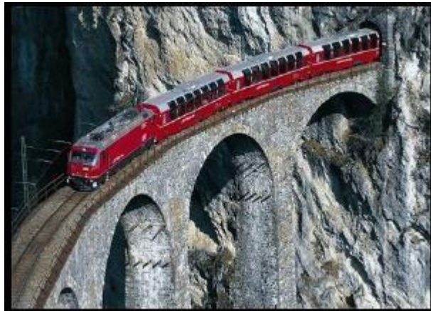
Figura 13. Puente para trenes
