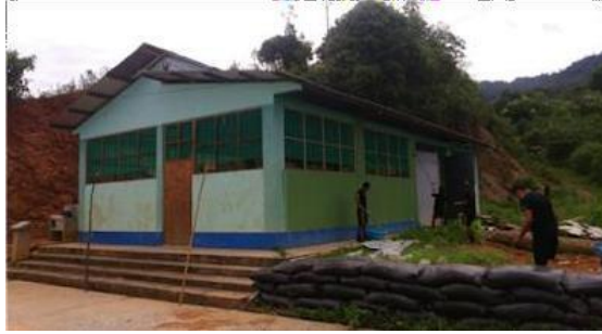
Figura 23. Instalación del campamento BALSAMUYOC.
