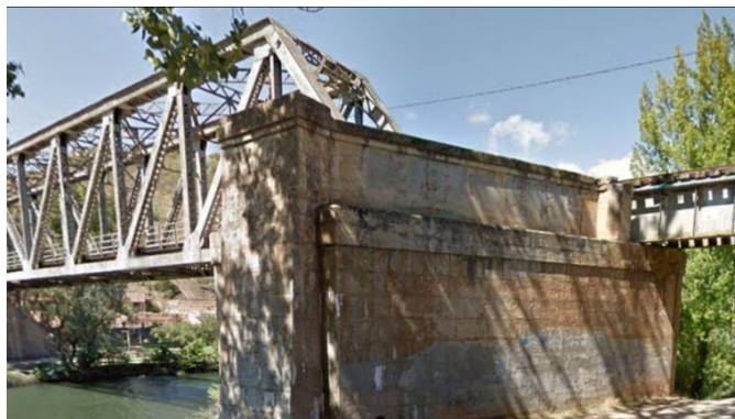
Figura 2. Estribo del puente de hierro Soria
