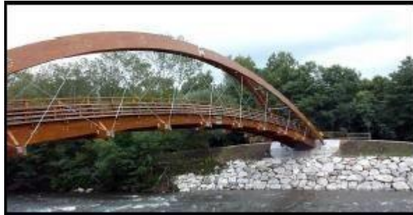
Figura 10. Puente de madera
