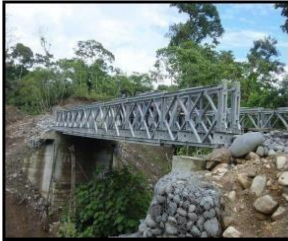
Figura 17. Puente Tipo Acrow
