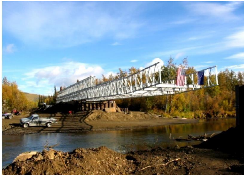
Figura 9. Puente tipo Acrow
