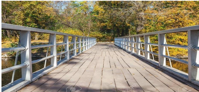
Figura 6. Barandas y acceso del puente
